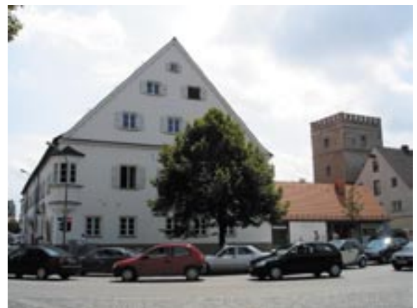
Nordfassade mit Neubau
