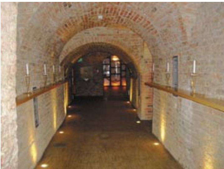
Historischer Gewölbekeller nach der Sanierung
